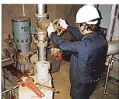
ポンプ類工事
